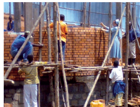
Budowa nowego domu zakonnego dla pallotynek w Kibehe.
